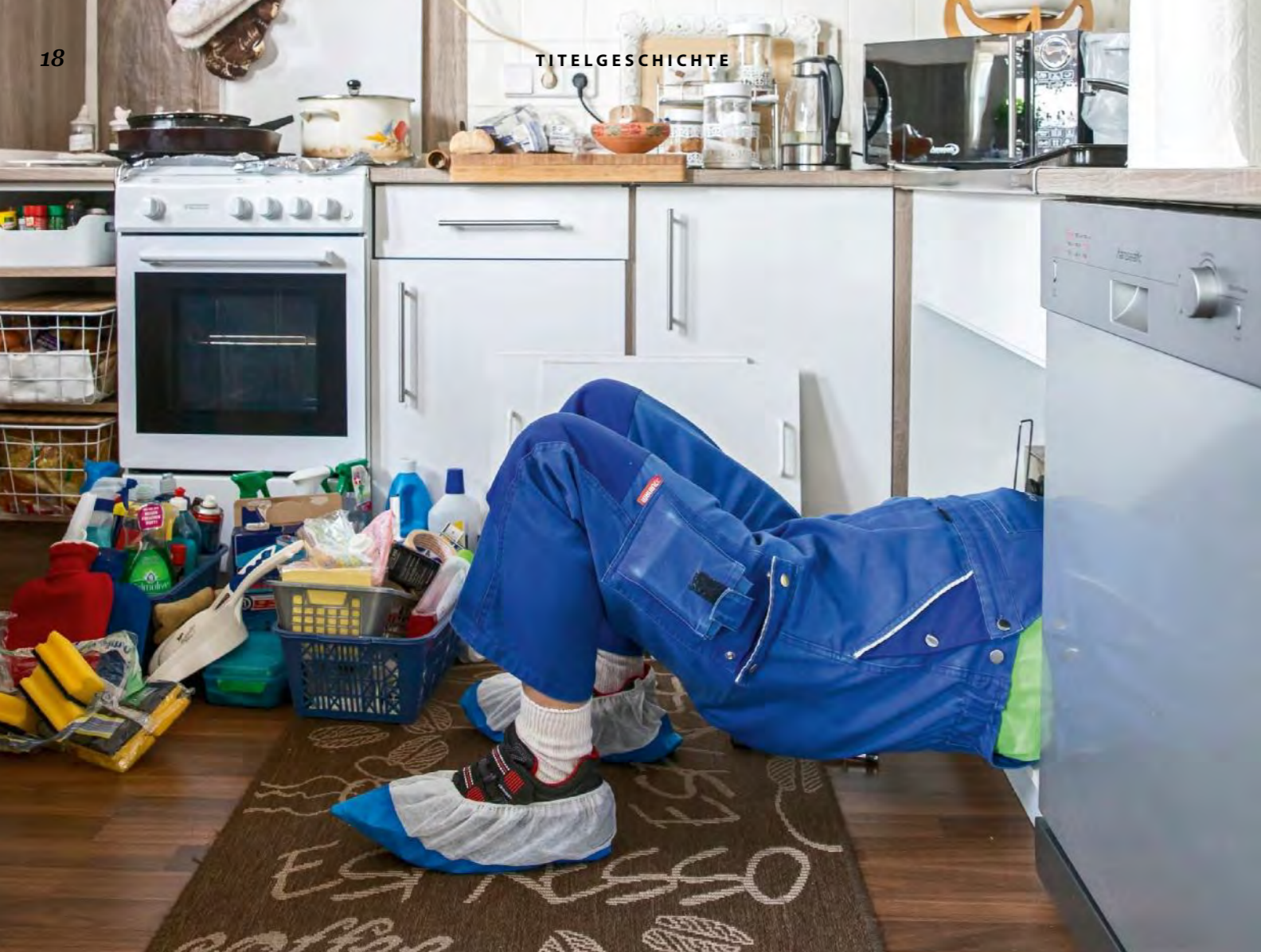
Tatort Spüle: Die Mischbatterie hat den Geist aufgegeben, der Hausmeister muss eine neue einsetzen. Also: Schrank ausräumen, reinklettern und die Zange ansetzen – mit Schuh-Überziehern, versteht sich. Michael Böttcher will ja nicht, dass die Mieter hinter ihm herputzen müssen
